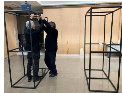
▲紙管を用いて撮影用のライティングフレームを組んでいる様子
