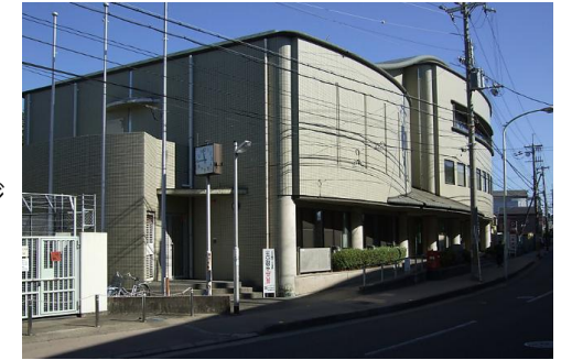
▲大山崎ふるさとセンター、大山崎町商工会が入る建物の2階が大山崎歴史資料館
